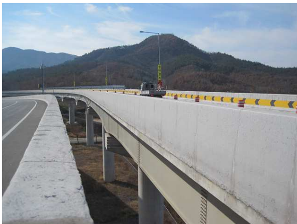
10공구 영천JCT R-A교
