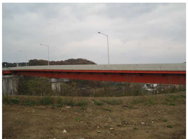
8공구 화산JCT R-H교
