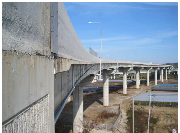
10공구 영천JCT R-B교
