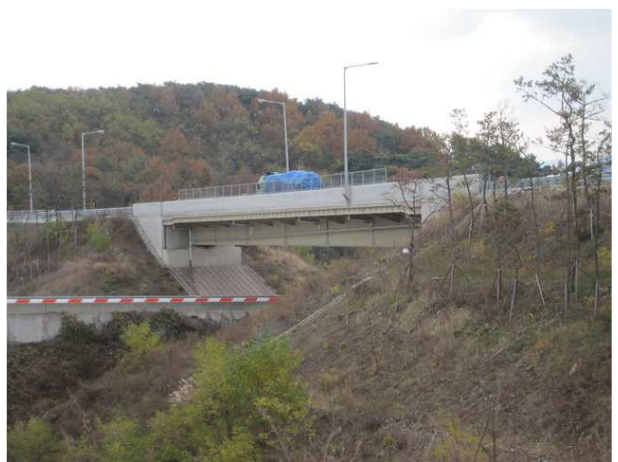
8공구 화산JCT R-A교
